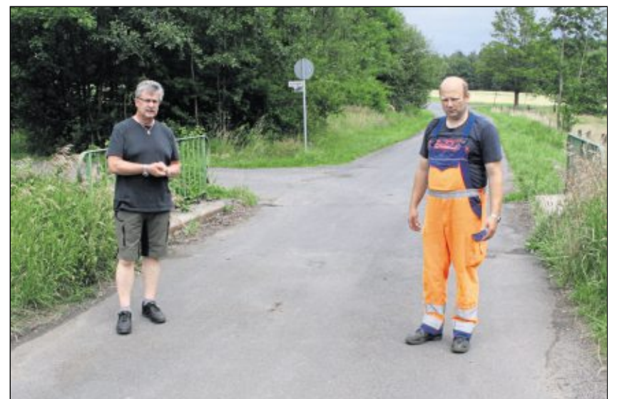
Inwieweit die kleine Brücke über den Wiesaubach in Mitleidenschaft gezogen wurde, bleibt offen. Bei einem Ortstermin machten sich Bürgermeister Wolfgang Braun (rechts) und stellvertretender Bauhofsleiter Rainer Kellner (links) auf jeden Fall ein genaues Bild vom Ort, wo vor Wochenfrist zwei Schwertransporter feststeckten. Bild: wro
